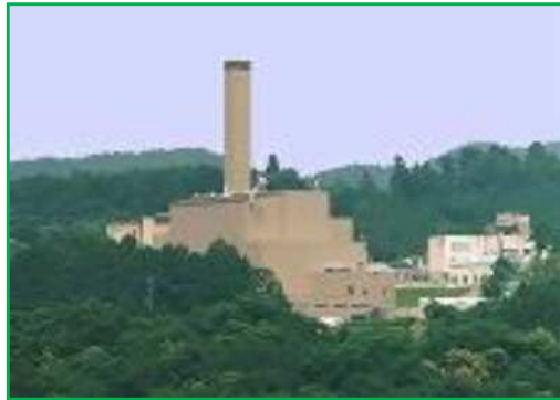
津久井クリーンセンター 〈緑区青山〉ごみ中継・し尿処理施設
