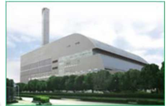
南清掃工場 〈南区麻溝台〉ごみ焼却施設
