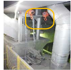
垂直ゲートに吊り治具を追加
